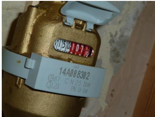
Unit C - A1plus meter 1
