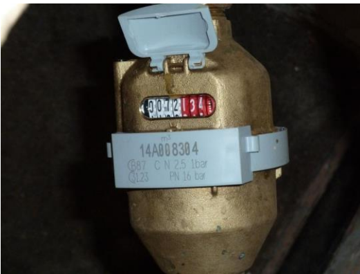
Unit C - A1plus meter 2
